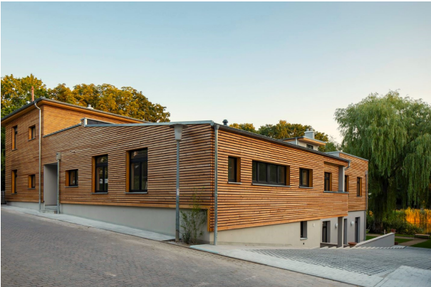
Fassade Stechlinseestr Ostseite
