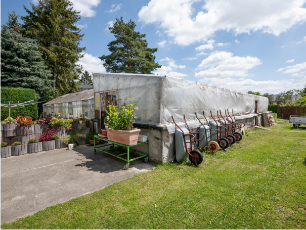
Abrissobjekt / Treibhaus - voll unterkellert
